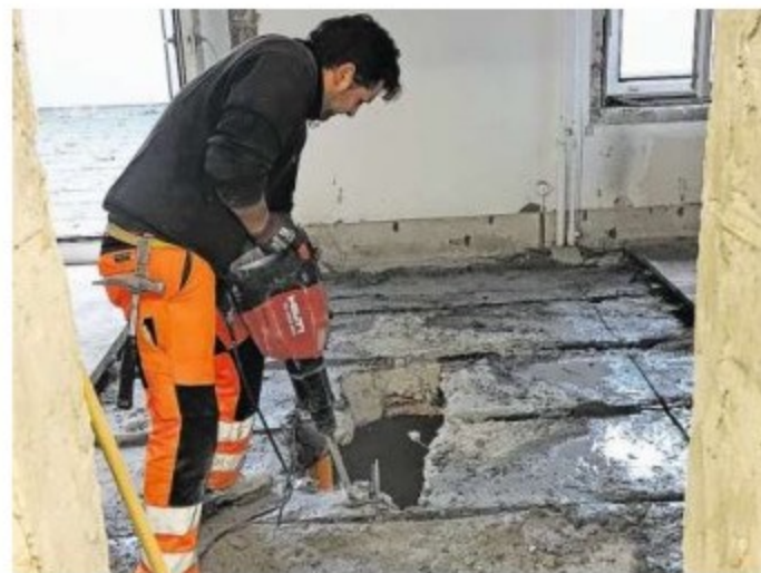
Die Decke wird durchbrochen, um dem Liftschacht Platz zu machen.
