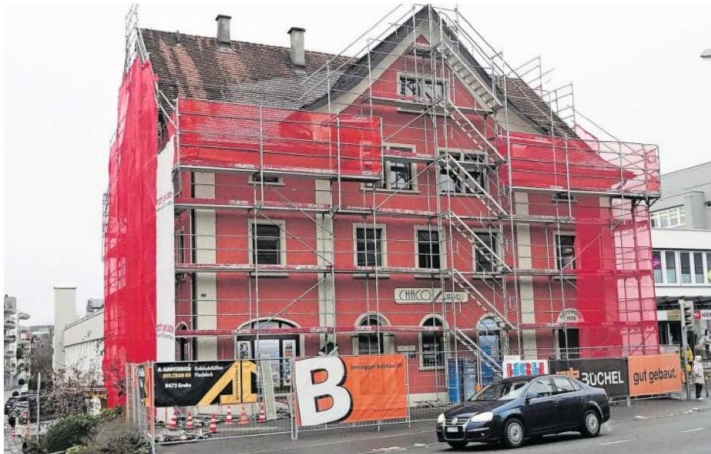
Rot eingepackt: Beim Diakoniehuis in Buchs haben die Umbauarbeiten begonnen.
